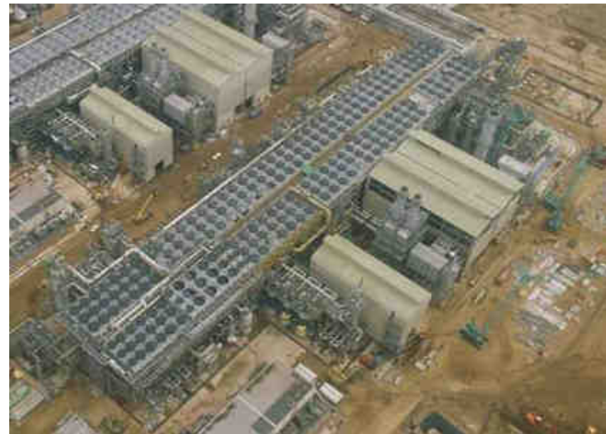
Refroidissement à l'air
