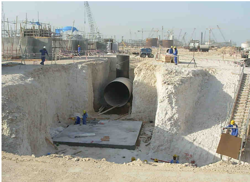
Refroidissement à l'eau
